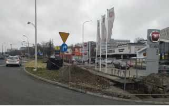
Budowa ścieżki rowerowej i chodnika wzdłuż al. Solidarności na wysokości PZMot.
