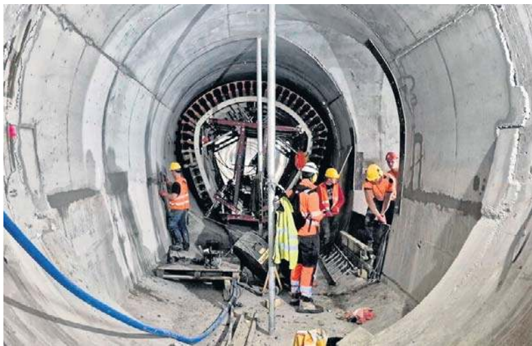
Nie ustają prace w tunelach wydrążonych przez maszyny TBM
