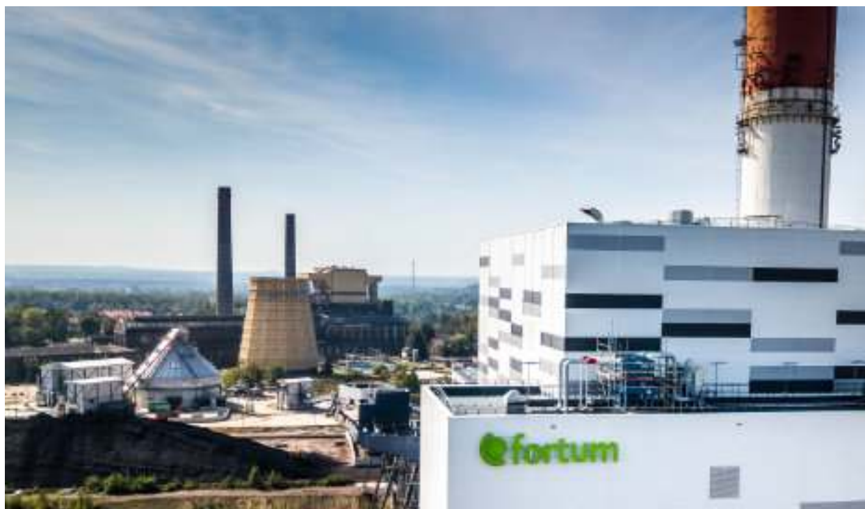
► Budowa w Zabrzu nowej elektrociepłowni była jedną z najważniejszych na świecie inwestycji fińskiej firmy Fortum Fot. Fortum
