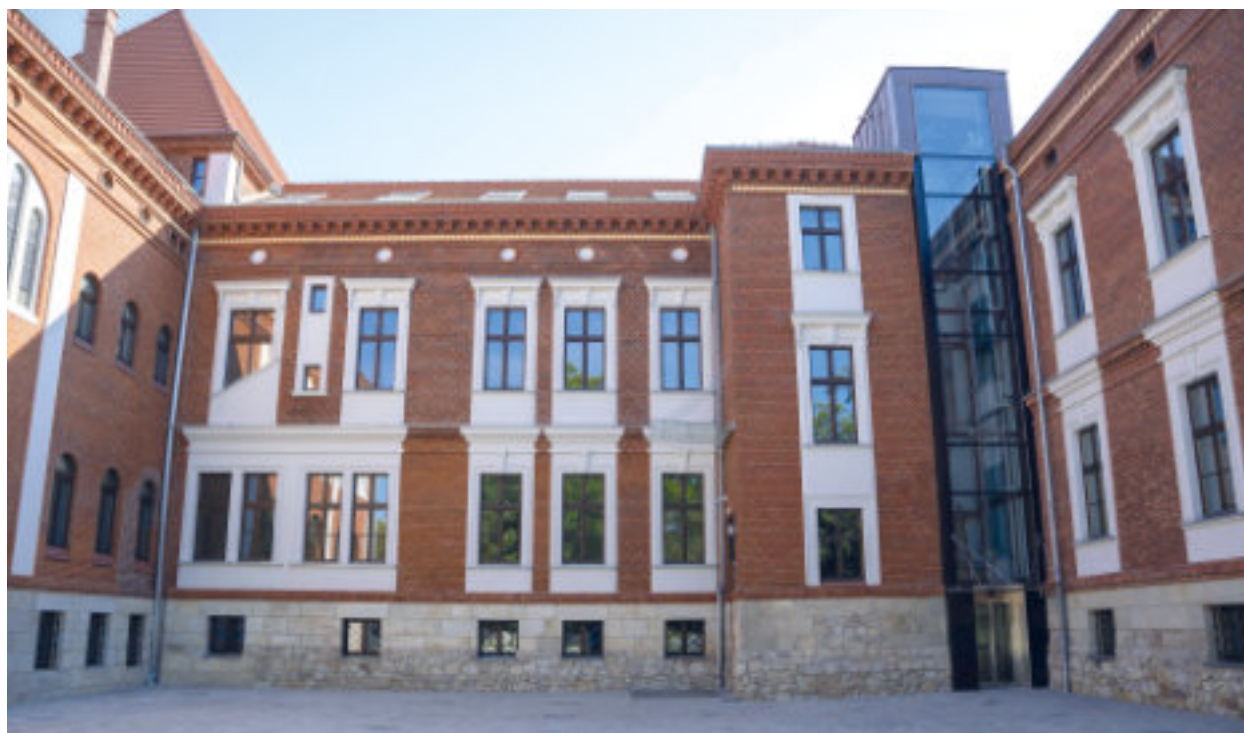
► Odrestaurowany budynek Muzeum Górnictwa Węglowego przy ul. 3 Maja Fot. UM Zabrze
