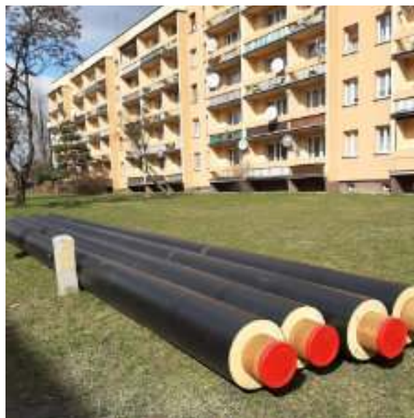
► Budowa sieci ciepłowniczej w Rokitnicy i Helence Fot. ZPEC
