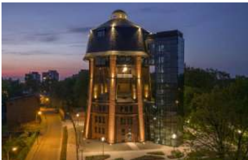
► Do zabytkowej wieży dobudowany został szklany segment z klatką schodową i windą Fot. MGW
