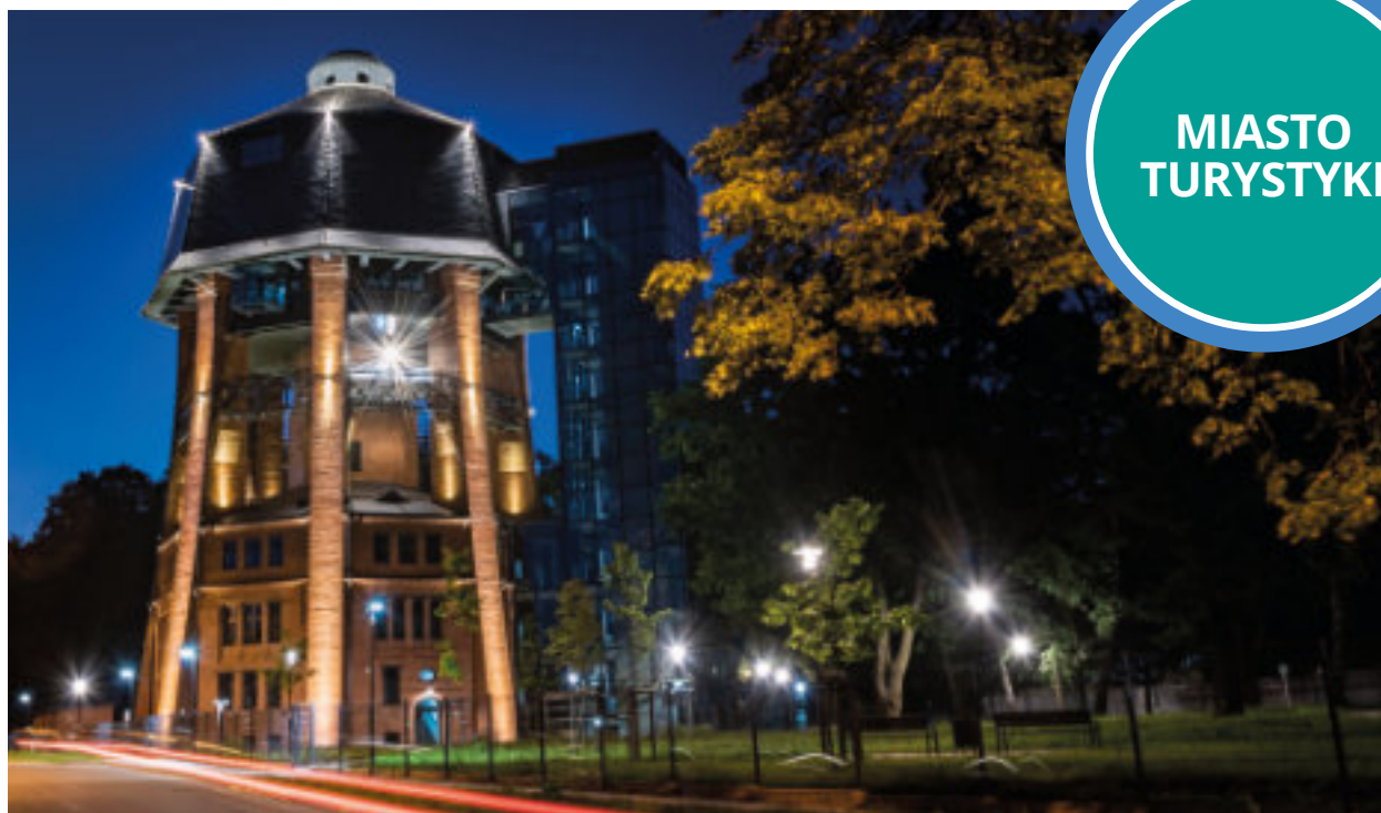
► Uratowana przez miasto przed rozbiórką wieża ciśnień przy ul. Zamoyskiego Fot. UM Zabrze
