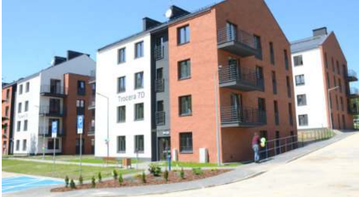
► Zrealizowane przez gminną spółkę ZBM-TBS osiedle przy ul. Trocera Fot. UM Zabrze
