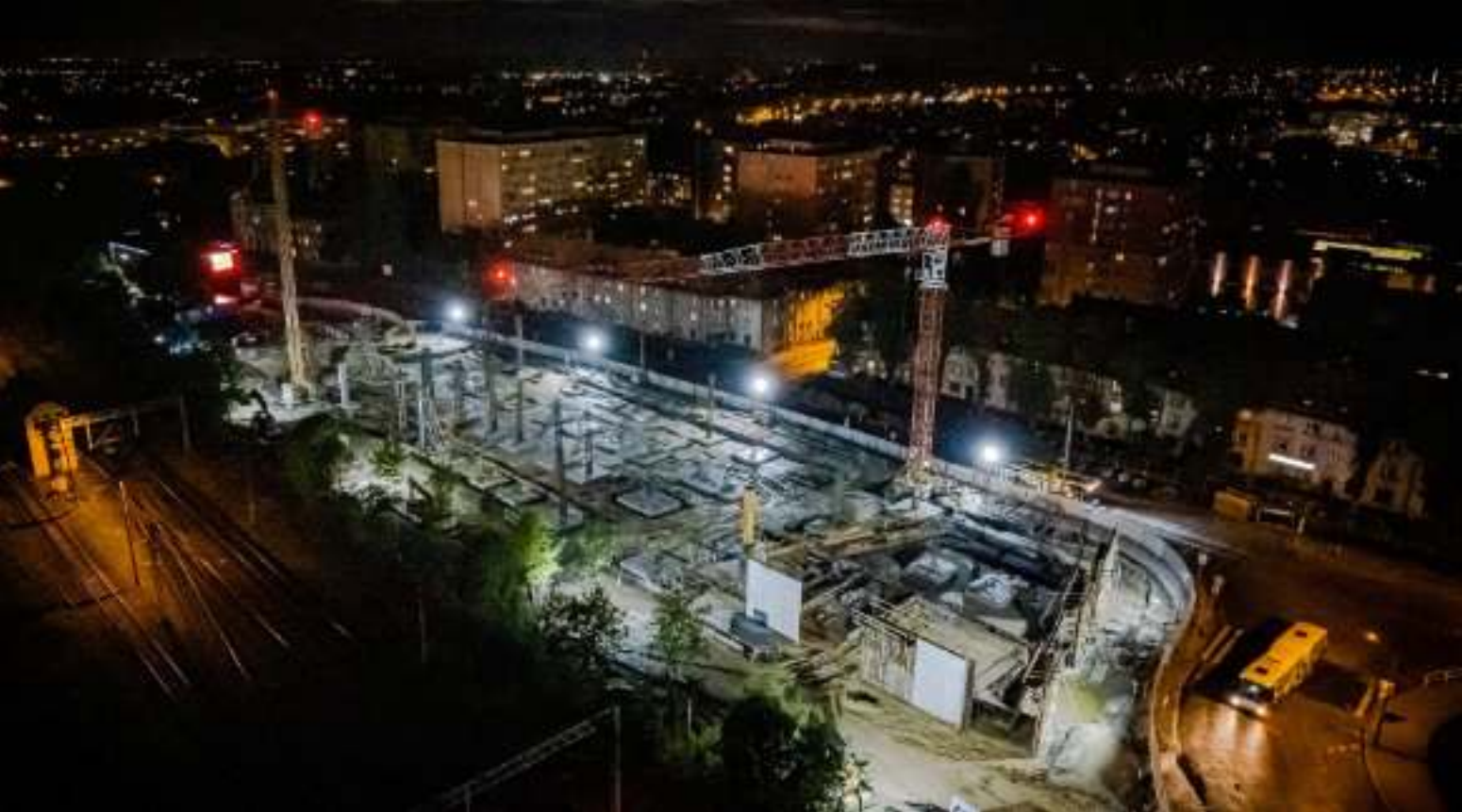
► Plac budowy przy ul. Goethego robi nocą spore wrażenie Fot. UM Zabrze
