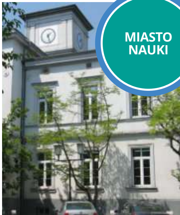
► Instytut Technologii Paliw i Energii Fot. UM Zabrze
