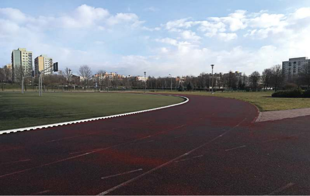
Bieżnia i mini boisko przy SP nr 16 jeszcze przed nowym rokiem szkolnym doczekają się remontu
