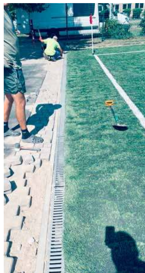
Oprócz nowej nawierzchni firma wybudowała też nowe obrzeża i odwodnienie
