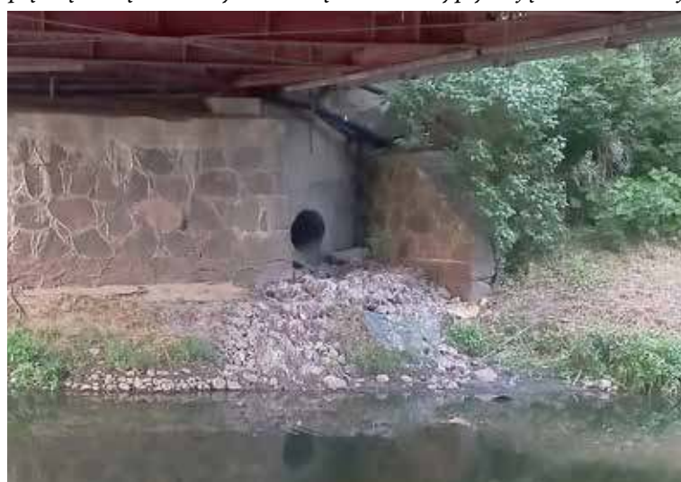
Co wyciekło z tej rury?
