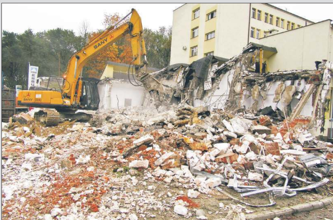
Praca w Dębickim Zespole Opieki Zdrowotnej wre. Ze szpitalnego krajobrazu zniknął budynek, na miejscu którego zostanie wybudowany nowy blok operacyjny. Łączny koszt jego budowy to 22 mln zł, z czego 8,5 mln zł to dofinansowanie z Regionalnego Programu Operacyjnego Województwa Podkarpackiego. Pozostała kwota, czyli 13,5 mln zł pochodzić będzie z kredytu. Dyrektor szpitala Przemysław Wojtys liczy jednak na to, że znajdą się kolejne źródła finansowania tej potężnej inwestycji.
