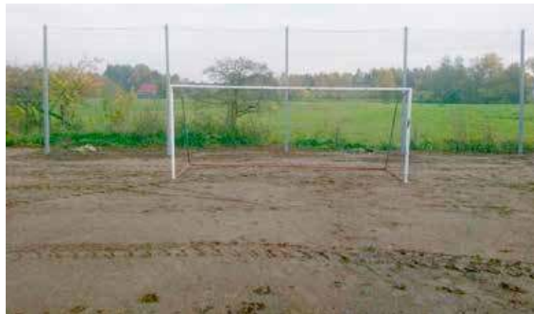
W ramach przedsięwzięcia zamontowano m.in. siatki mające na celu łapanie piłek na boisku (fot. Gmina Przybiernów)
