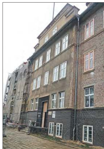
Realizowana przez Starostwo termomodernizacja ZOL w Głogówku. O działania remontowe wielokrotnie upominali się radni Dragomir Rudy i Kazimierz Bodaszewski
