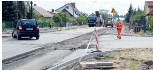
Pora na rozstrzygnięcie przetargu i podpisanie umowy z wykonawcą.
