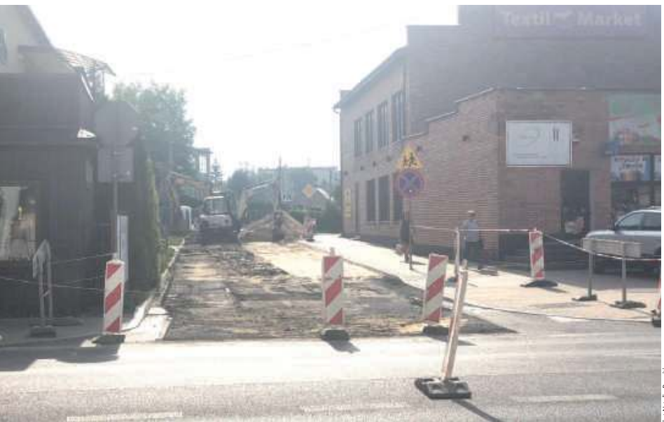
Modernizacja ulicy Piłsudskiego w Biłgoraju. Widok od strony ulicy Kościuszki
