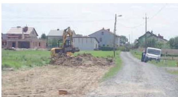
Nowa droga ma „poprawić atrakcyjność tych terenów”
