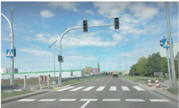
Przejście dla pieszych wciąż jest zagrodzone pachołkami i pionowymi barierkami, co wyraźnie wskazuje o braku możliwości z jego korzystania
