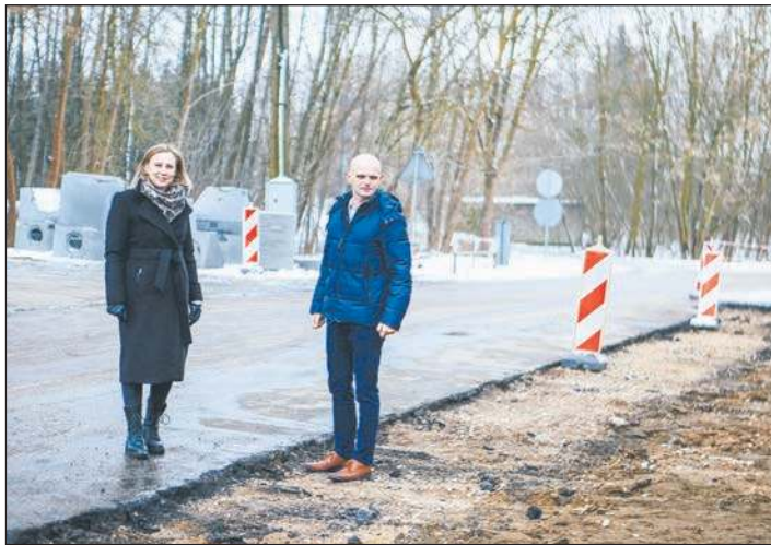
Trwa rozbudowa drogi powiatowej Wilkanowo – Gródkowo
