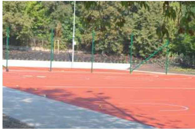
Przy SP nr 3 im. Jana Brzechwy prace nad częściową budową boiska szkolnego rozpoczęły się w ubiegłym roku. Tak prezentuje się boiska do gry w koszykówkę
