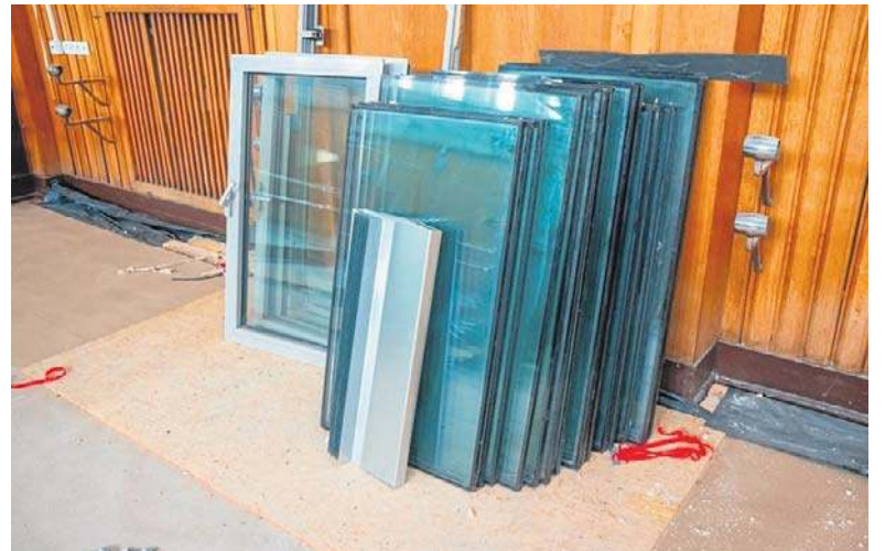
Nowe okna mają poprawić izolację termiczną i ograniczyć straty energii.
