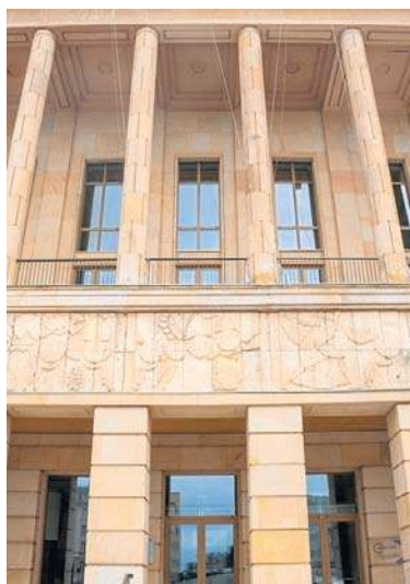
Wszystkie roboty prowadzone są pod nadzorem konserwatora.
