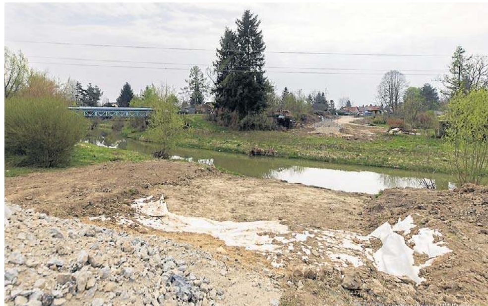
Trwające teraz roboty na os. Drabinianka mają umożliwić wzmocnienie koryta rzeki Strug w miejscu, gdzie powstanie kładka dla pieszych i rowerzystów.
