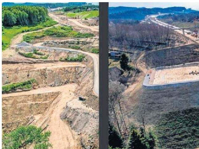
Zbiornik umożliwi kontrolowane odprowadzanie wód opadowych
