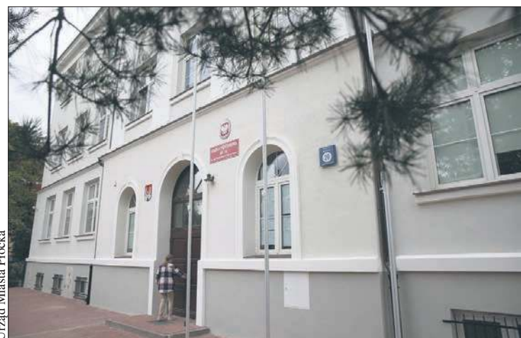
Elewacja SP 14 po remoncie
