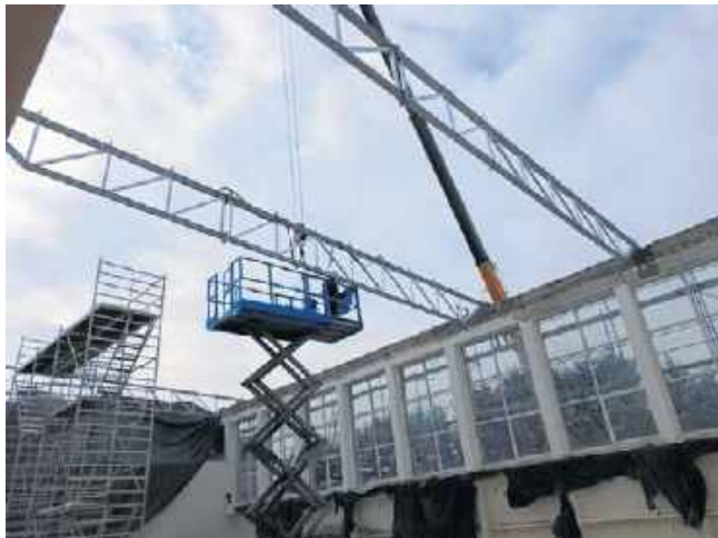
Wielki remont szkoły w Pacanowie. Z uwagi na zły stan techniczny, konieczna była wymiana dachu hali sportowej
