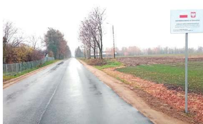
Zakres przebudowy obejmował m.in. wykonanie tzw. warstwy wyrównawczej i ścieralnej z betonu asfaltowego
