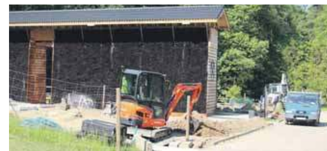
Przy tężni trwają prace budowlane, powstaje tam amfiteatr
