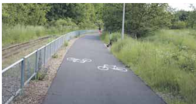
Promenada rowerowa wzdłuż torów wąskotorówki ma zostać przedłużona aż do granicy Bytomia
