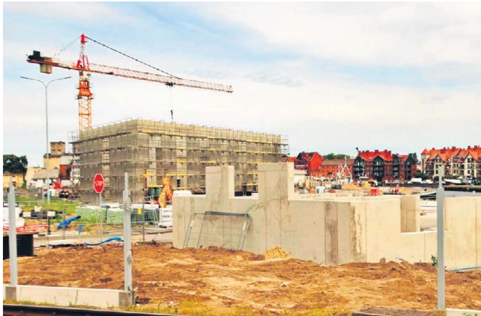
Budowa bazy PGE Baltica w Ustce. Obiekt powstaje po zachodniej stronie kanału portowego
