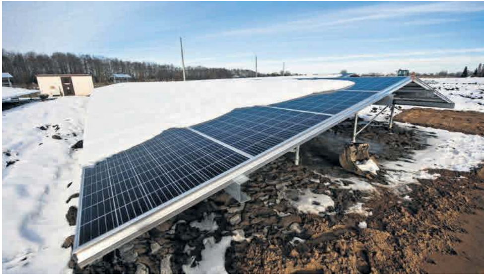
W tej chwili trwają prace związane z podłączeniem elektrowni z punktem odbioru energii przez obiekt oczyszczalni
