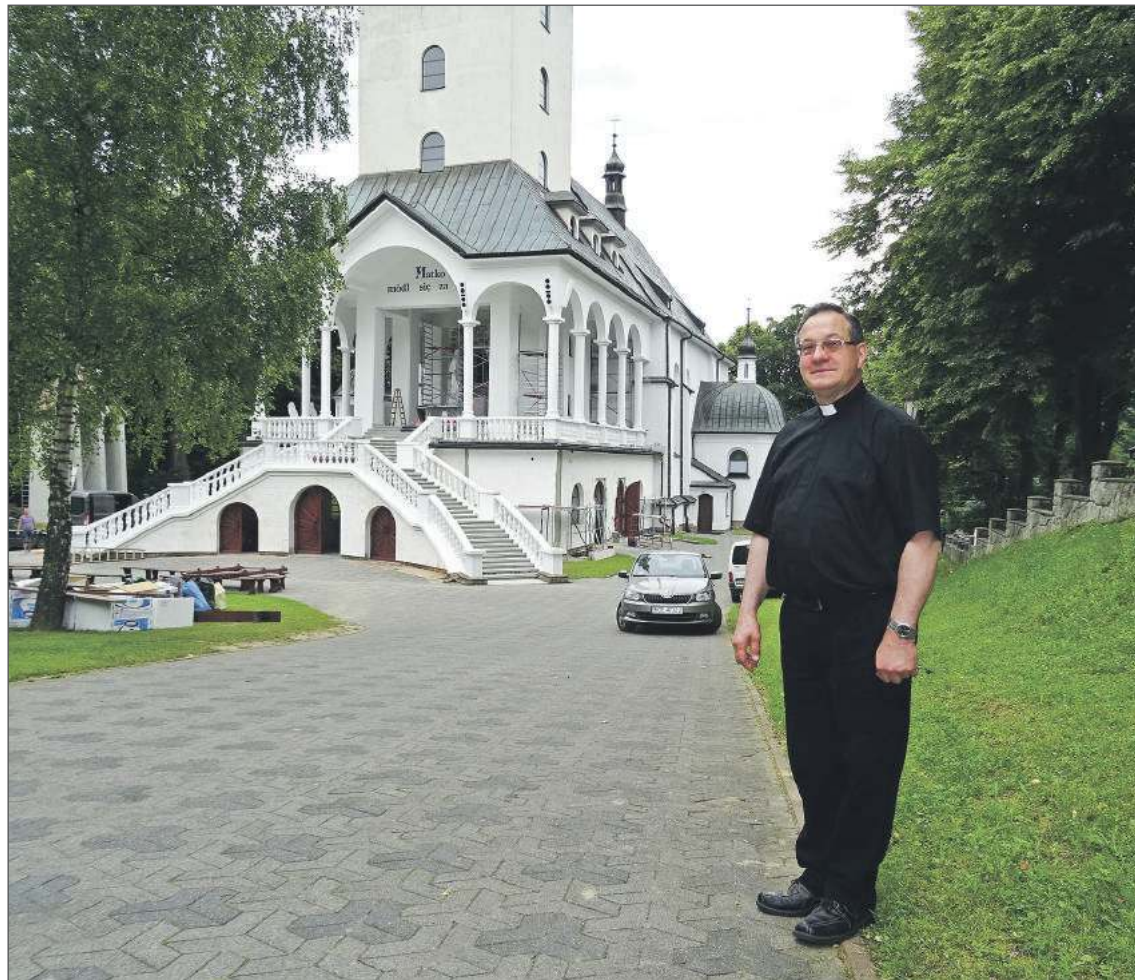
Ks. Józef Książek cieszy się, że prace remontowe przy sanktuarium powoli zbliżają się do końca.
