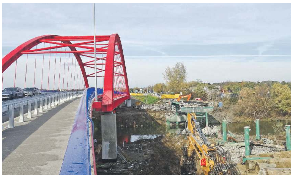
Budowa mostu pomiędzy Dębicą a Straszęcinem oraz pozyskane na ten cel dotacje to elementy, które przyczyniły się do wysokiej pozycji powiatu dębickiego w rankingu finansowym samorządów.
