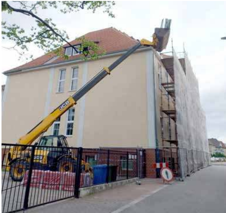
Prace obecnie koncentrują się na wschodniej części dachu budynku
