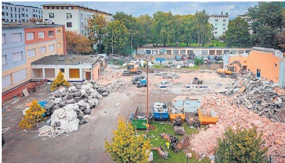
Rozbiórka sali gimnastycznej przy Szkole Podstawowej nr 97. Na tym miejscu zostanie wybudowany nowoczesny obiekt
