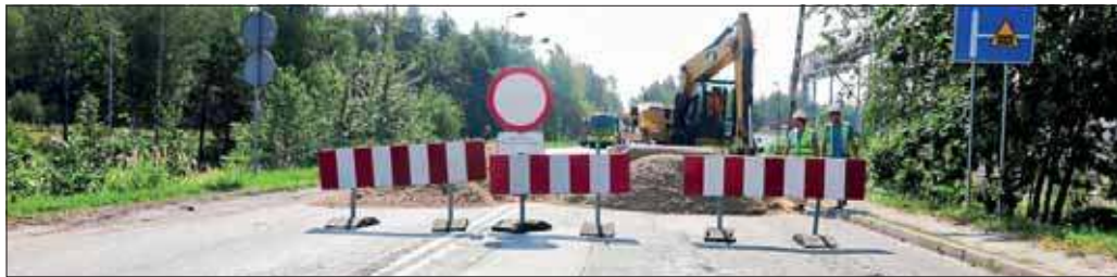
Remont drogi potrwać ma 3 miesiące
