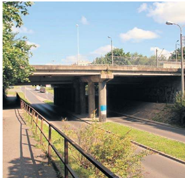
Wykonawca będzie miał rok na realizację inwestycji związanej z remontem wiaduktu
