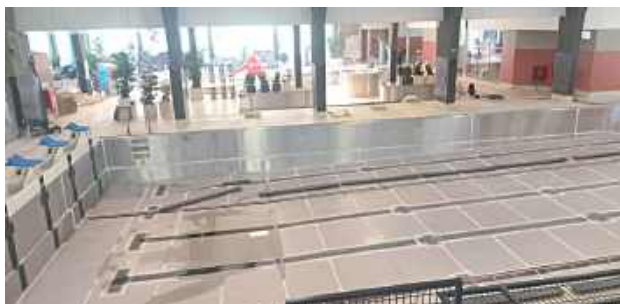
Wewnątrz inwestycja jest już na ukończeniu
