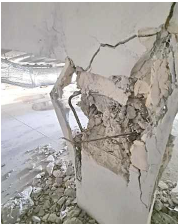
Tak wygląda uszkodzony słup żelbetonowy podpierający nieckę basenową
