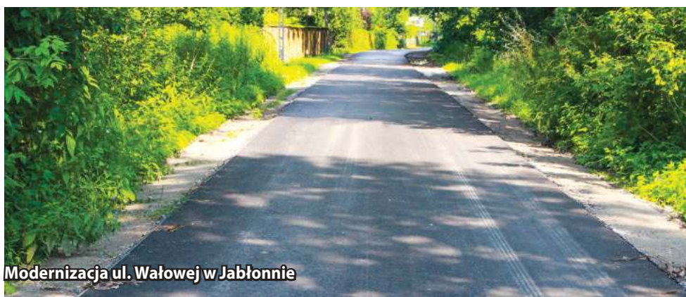
Modernizacja ul. Jagiellońskiej w Jabłonce
