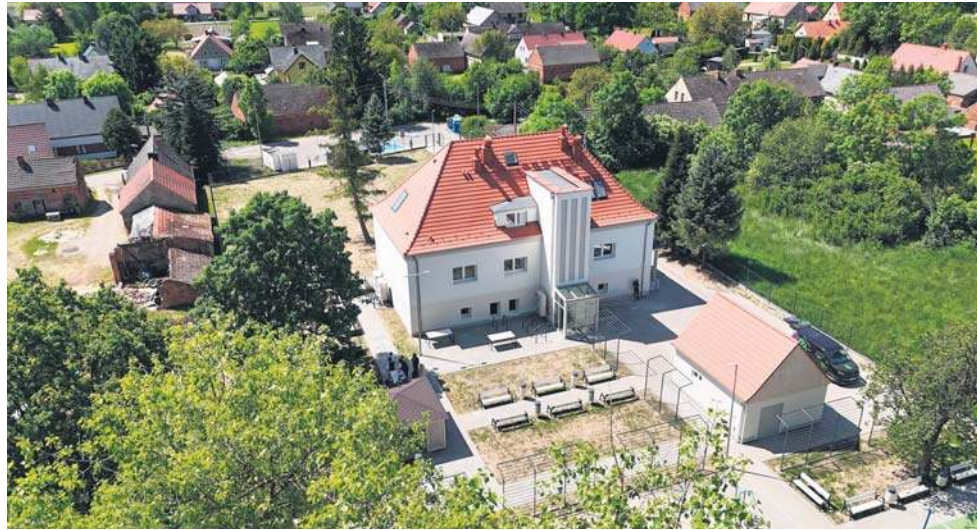
Rewitalizacja budynku dawnej szkoły podstawowej w Koźli. FOT. CADPRO BIURO PROJEKTÓW I EKSPERTYZY BUDOWNICTWA
