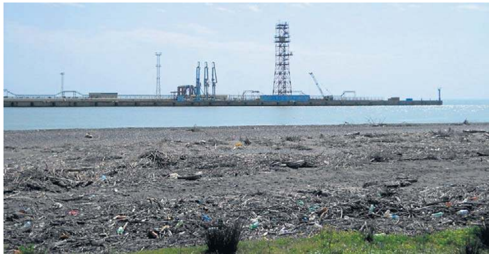
Nowa gruzińska rafineria Kulevi przyjmuje ropę z Rosji. Zakład nad Morzem Czarnym rozpoczął działalność w październiku
