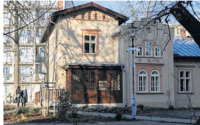
W Kossakówce trwają ostatnie prace kosmetyczne
