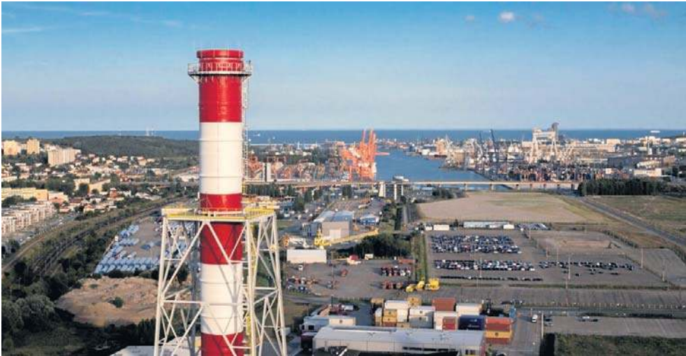
Niedawno elektrociepłownia w Gdyni zyskała kotły olejowo-gazowe, za trzy lata będzie miała instalację do spalania biomasy
