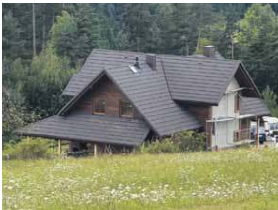
Samowola budowlana w Harklowej
