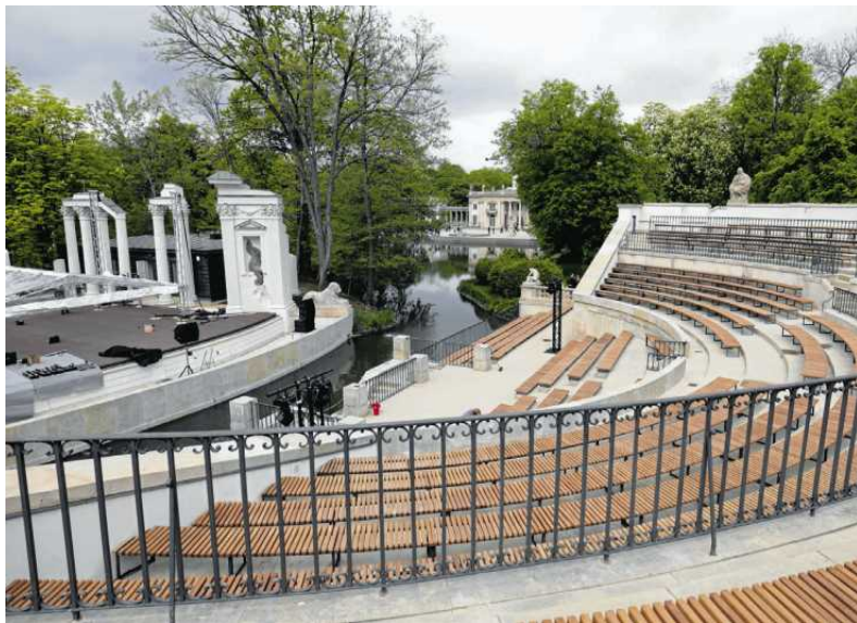
• Amfiteatr w Łazienkach Królewskich po remoncie
