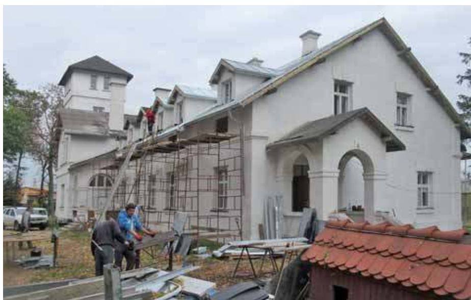
Właściciele już naprawiają dach
