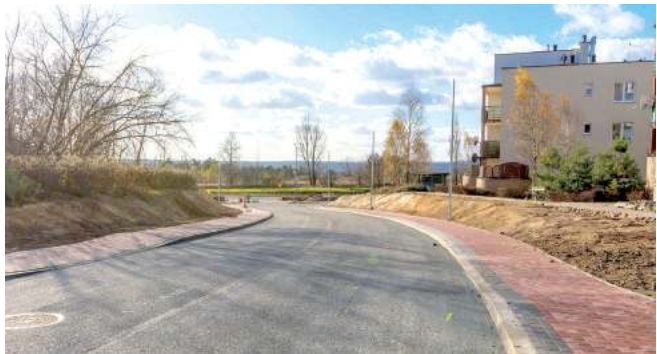
Tak teraz wyglądają drogi w osiedlu Słoneczne Piaski. Po betonowych płytach i błocie nie ma śladu
