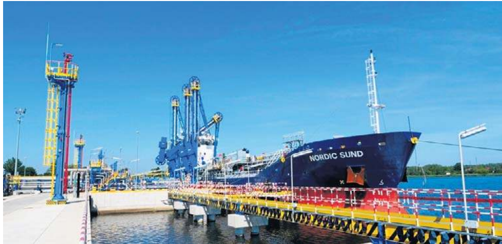
Terminal Orleu na Martwej Wiśle rozpoczął komercyjną działalność
