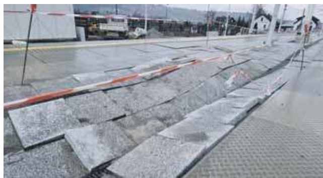
Tak wygląda otwarty w grudniu peron na dworcu PKP w Zakopanem.
