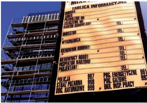
Budowa przeszklonego białskiego biurowca ma tablicę informacyjną, na której czas „zatařit ślad”. Kto chce, może sobie wyobrazić wiele...
