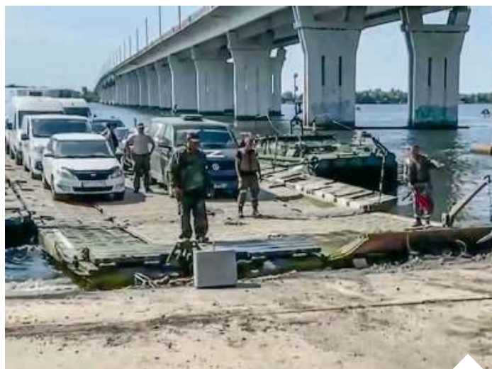
Rosja rozpoczęła prace przy budowie mostu pontonowego przez Dniepr w Chersoniu w pobliżu uszkodzonego mostu Antonowskiego | fot. Twitter/d
