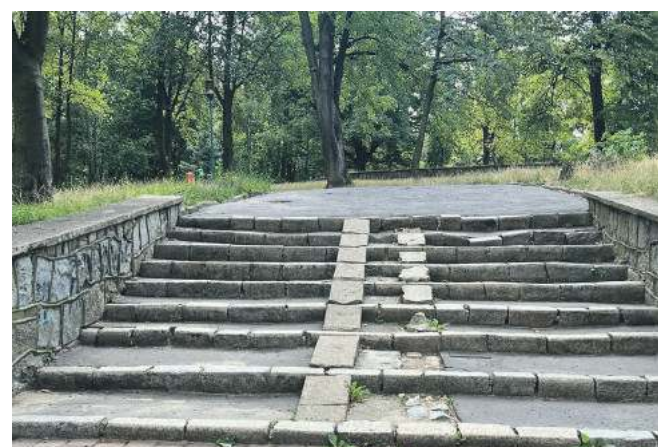
Z przetargu usunięto remont schodów od ul. Parkowej
