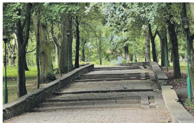
Usunięto też remont schodów od ul. Bochenka
