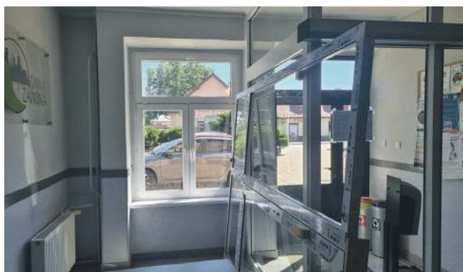
Rozpoczęto remont w Urzędzie Gminy Zawonia
