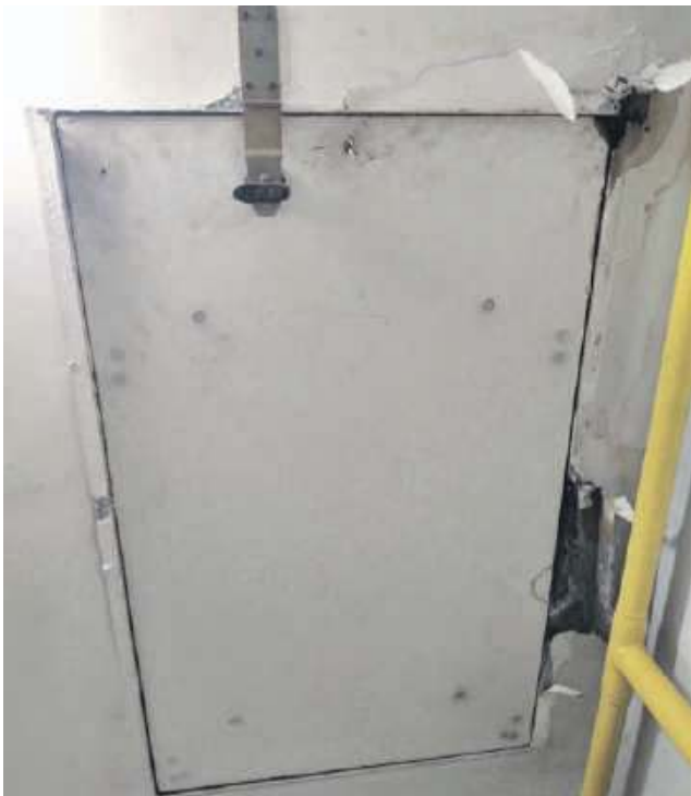
Tak wygląda wyjazd na dach
