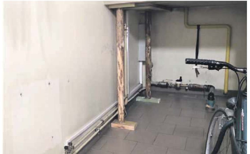
Schody w dobudowanej klatce schodowej przy ul. Młyńskiej podparto stemplami, bo zaczęły odchodzić od budynku, a po kaloryferach został ślad na ścianie
