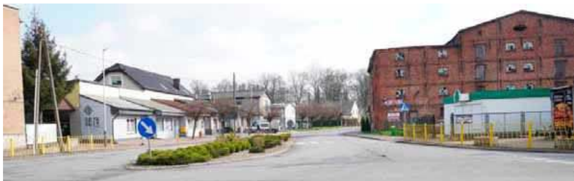
Ulica Nowogardzka w Maszewie ma szansę na nową nawierzchnię (fot. Gm. Maszewo)
