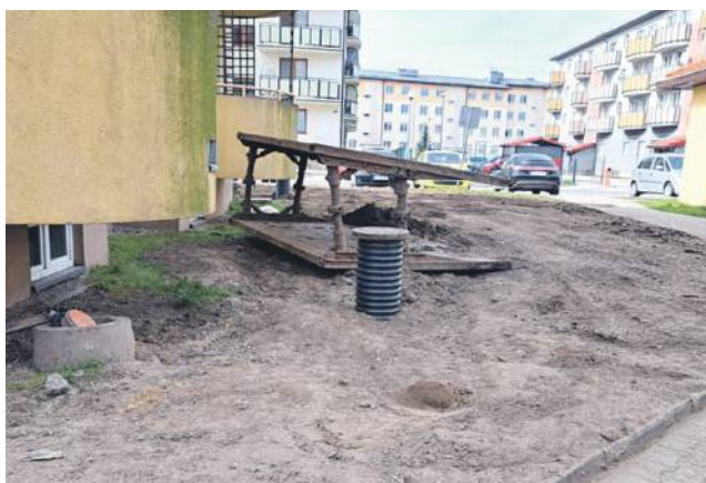
- Od kilku tygodni wokół naszych bloków wykonywane są prace drenażowe, ale sposób ich wykonywania budzi wiele zastrzeżeń - mówi mieszkaniec TBS
