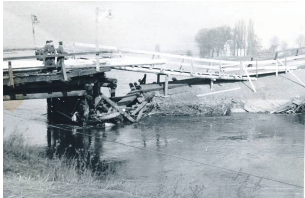
1963 - tymczasowa kładka na uszkodzonym moście
