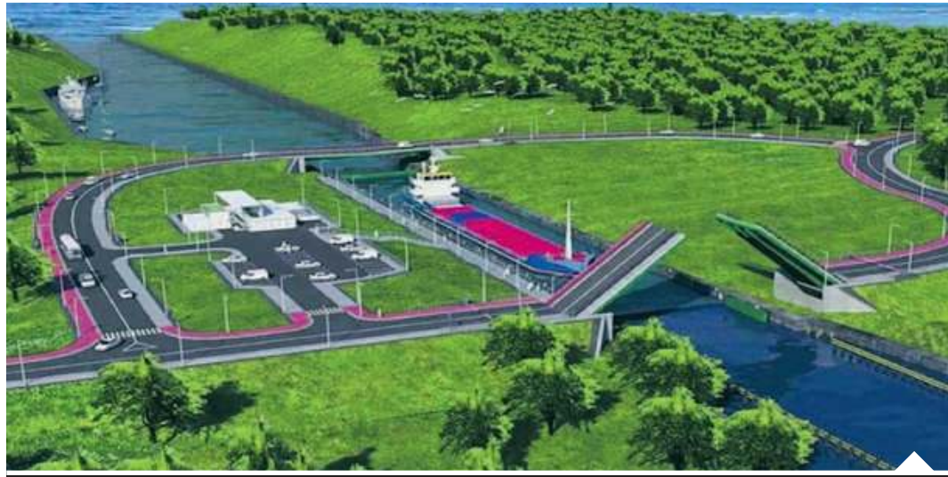
Mimo pandemii budowa kanału przez Mierzę Wiślaną i związanej z nim infrastruktury wciąż trwa | fot. mat. pras./d
