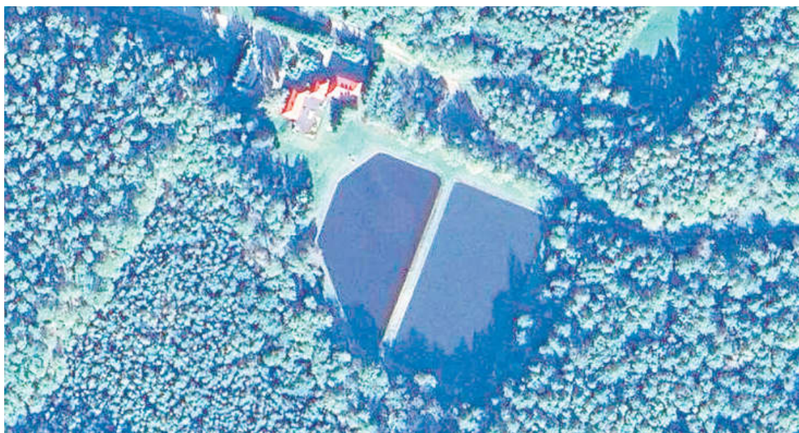
Teren oczyszczalni ścieków Serpelic
