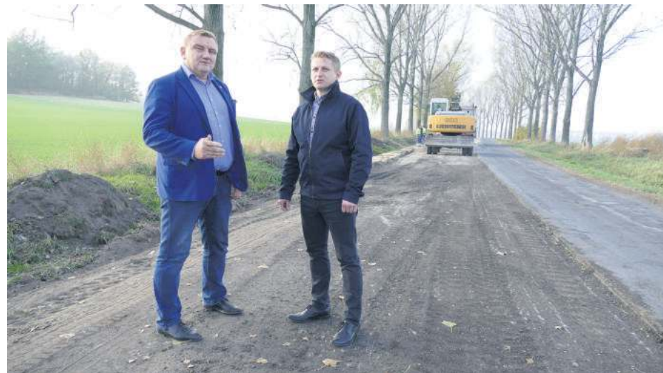
Postępom prac na przebudowywanej drodze powiatowej ze Strzelina do Jegłowej przyglądali się w miniony czwartek Marek Czerwiński, starosta strzeliński (z lewej) i Zdzisław Ziąber, dyrektor Powiatowego Zarządu Dróg w Strzelinie
