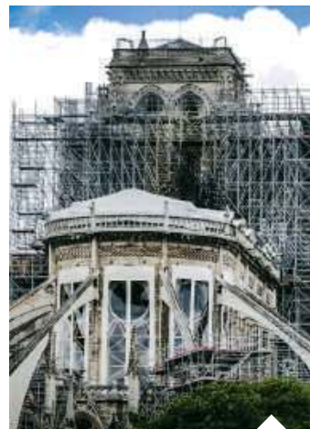
Pożar wybuchł w kwietniu 2019 r. Jego przyczyną było spięcie w instalacji elektrycznej | fot. mat. pras./d
