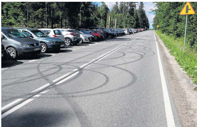
Droga do Morskiego Oka - ślady na jezdni są wyraźnie widoczne
