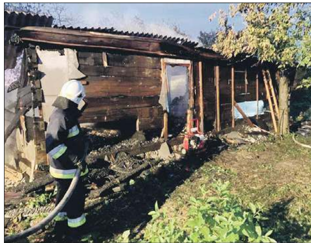
Ciało 67-letniego mężczyzny strażacy znaleźli na podłodze w kuchni, było przysypane częściowo spalonymi elementami konstrukcji stropu i dachu
